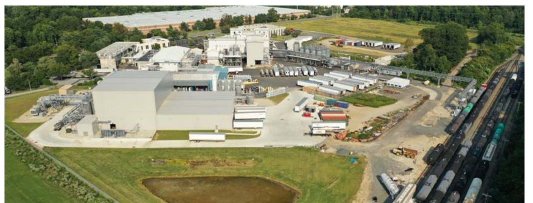
Nella foto: IMPIANTO C.O.I.M. - USA
