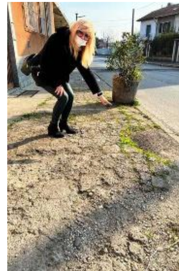
Precaria la situazione dei marciapiedi
